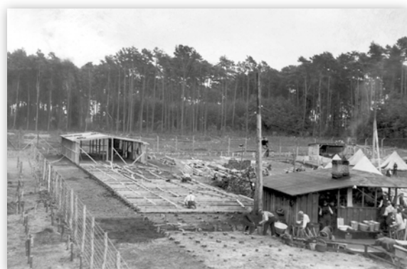
Jesień 1939 r. - budowa pierwszych baraków obozu KL Stutthof
